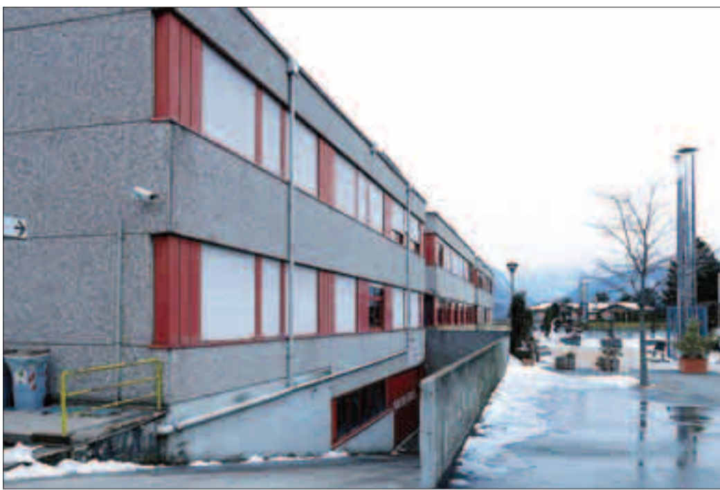
La caserma dei vigili del fuoco di Cognola: problemi di sicurezza per l'accesso (Foto Piero Cavagna)
